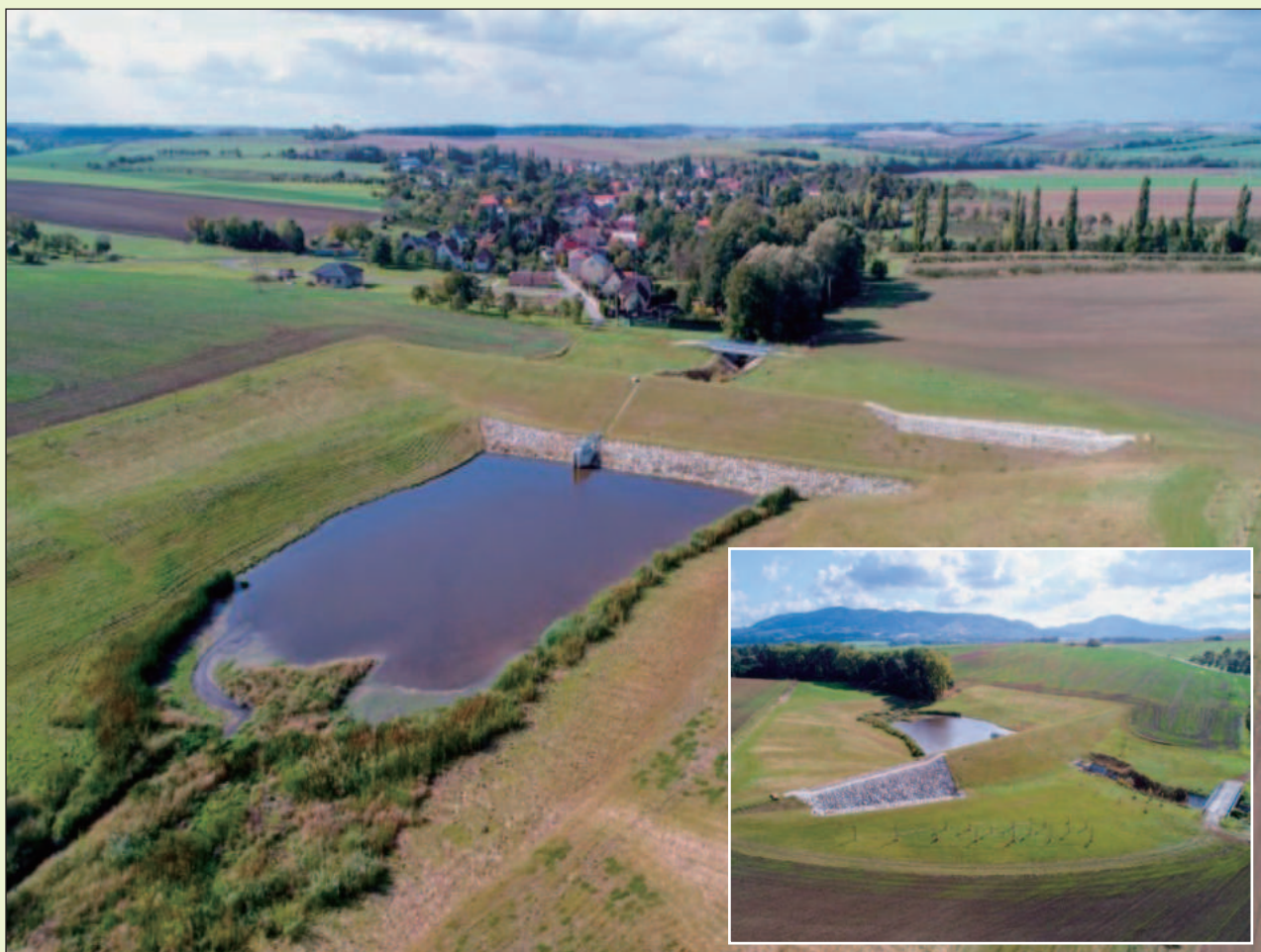
Obrázek 11/12: Stav po realizaci – retenční nádrž – celk. pohled
