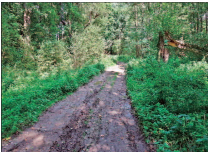
Obrázek 7: Stav před realizací
