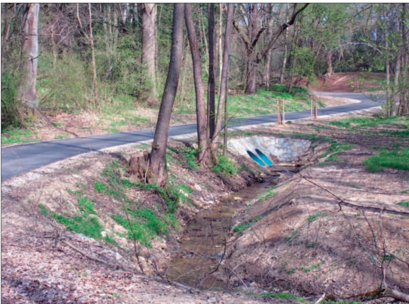
Obrázek 9: Stav po realizaci – polní cesta s odvodněním
