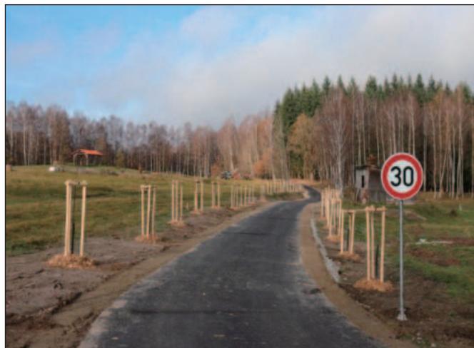
Obrázek 8: Stav po realizaci – polní cesta s výsadbou
